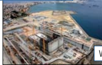
Construction of LNG terminal in Spain
